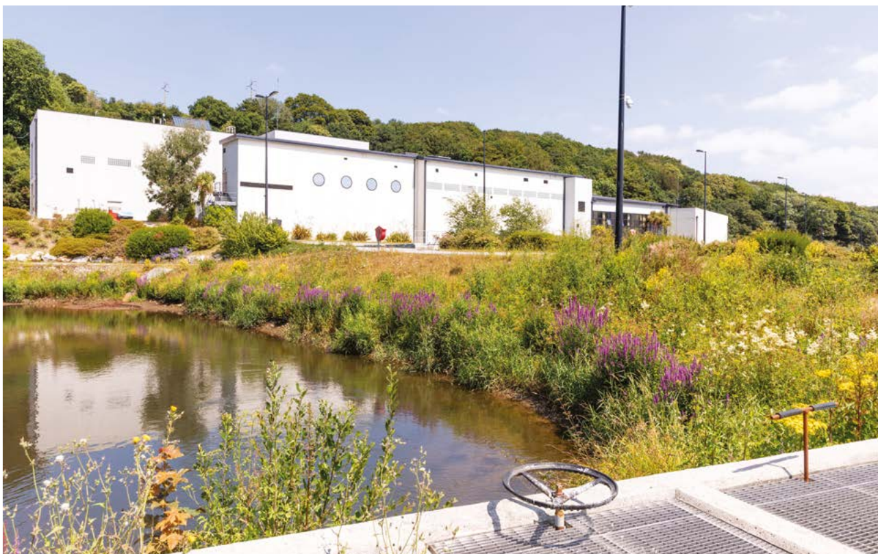
L'usine d'eau de la Divette dans la vallée de Quincampoix.
