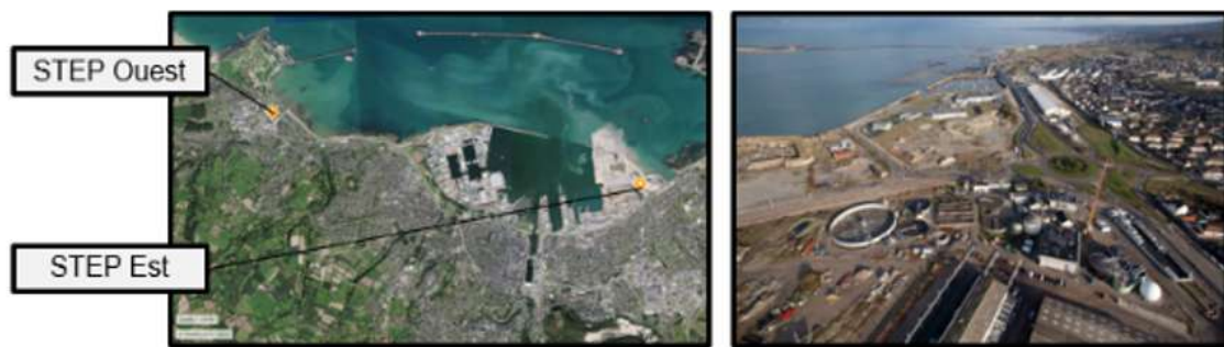
FIGURE 127. ILLUSTRATIONS DES STATIONS D'ÉPURATION DE CHERBOURG-EN-COTENTIN
