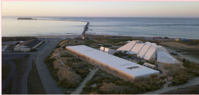
Réalisation des études préalables aux travaux de rénovation d'Intechmer
