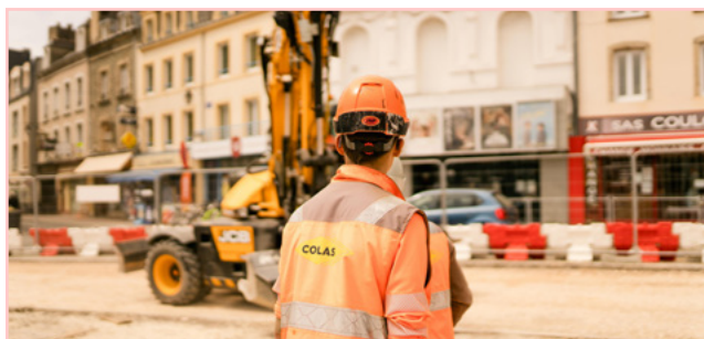
Chantier du Bus Nouvelle Génération
