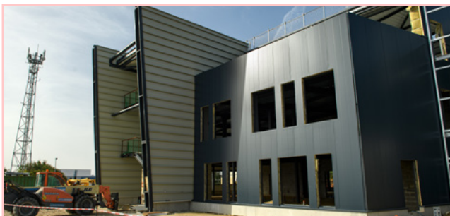
Construction de l'école d'excellence de soudage Héfaïs
