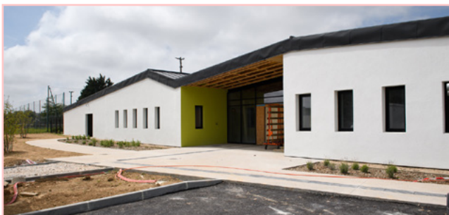
Construction du Pôle enfance de Montebourg
