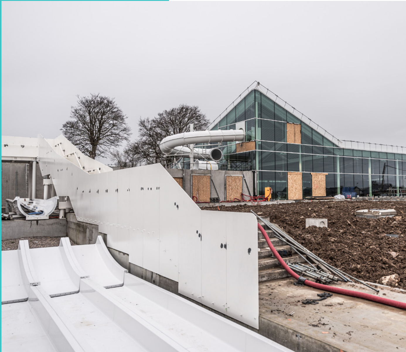
Les bains du Cotentin, nouveau centre aquatique de Valognes, en construction.
