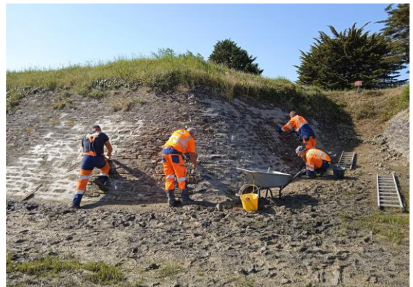
Travaux d'aménagement d'une digue, 2024
