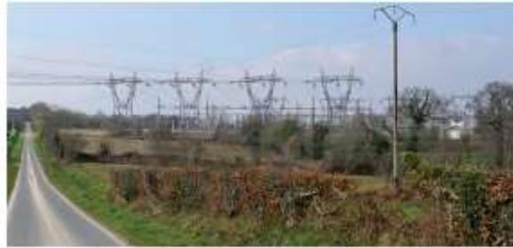
*Figure 26 : Dans l'axe des faisceaux de lignes électriques 400 kV, le poste électrique est plus visible (ici en arrière des pylônes), la végétation étant régulièrement rabattue sous les lignes. (Source : Atelier de l'Isthme)*
