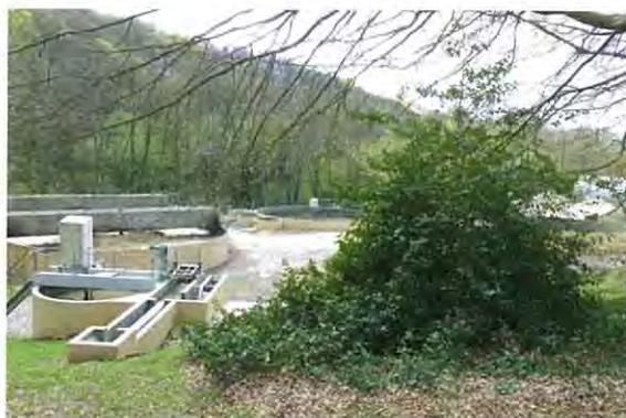
Avec 380 m<sup>3</sup> traités par jour, la station des Pieux n'est pas en surcharge hydraulique. Sa capacité nominale est de 750 m<sup>3</sup>, elle fonctionne donc à 52 % de sa charge nominale. Le raccordement d'une partie de la commune de Benoistville sera réalisé sur cette station. L'eau épurée est de bonne qualité physico chimique. La charge organique est en légère hausse pour s'établir à 50 g/EH/j de matières sèches.
