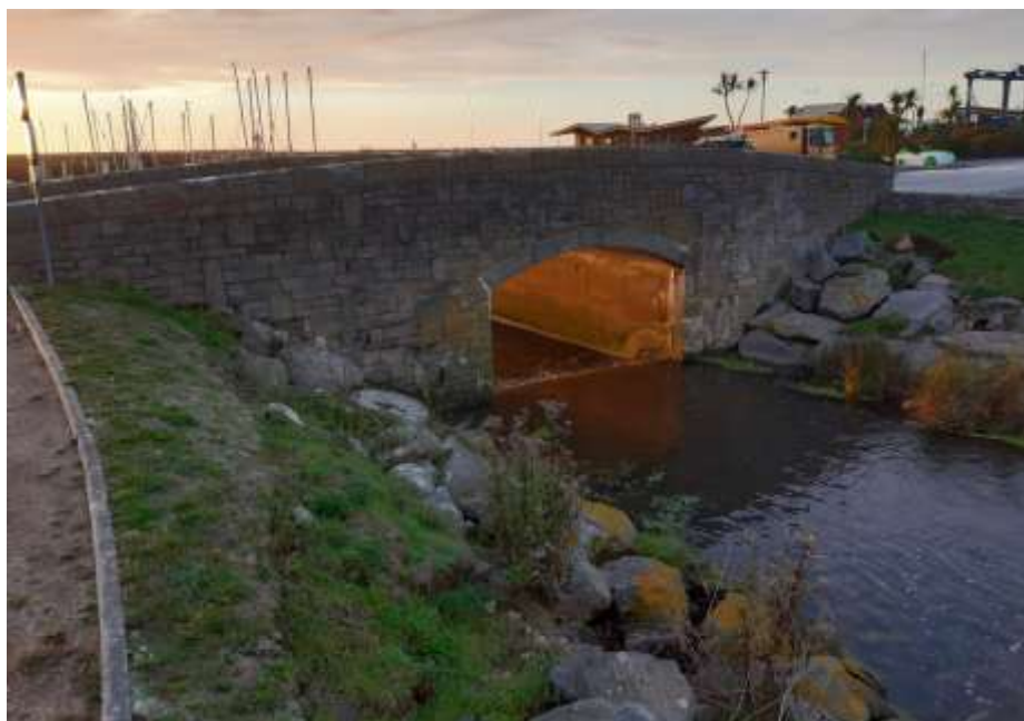
Figure 3 : Vue du pont (lieu d'implantation de la nouvelle station) depuis l'amont
