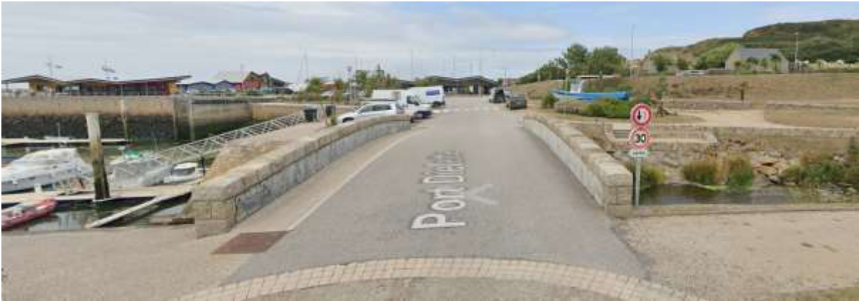
Figure 1 : Vue du pont (lieu d'implantation de la nouvelle station) en arrivant dans le port de Dielette (source : Google Maps)
