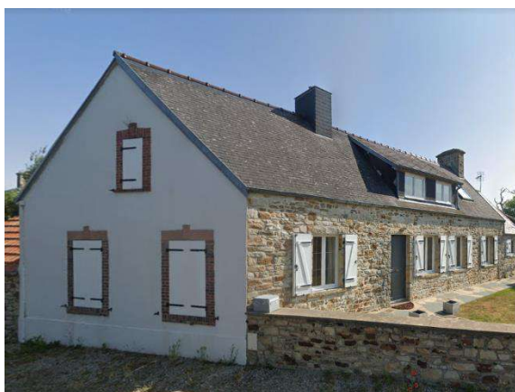
Exemple de logement ancien dans le bourg de la commune (secteur UB)
