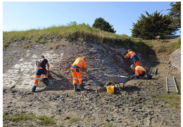
Travaux d'aménagement d'une digue, 2024
