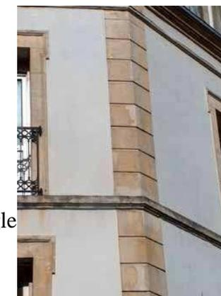
**Chaîne** : Pile en pierre de taille ou autres matériaux appareillés et parementés, incorporée dans un mur, pour l'affermir, particulièrement aux angles. Chaîne d'angle Pile en pierre incorporée dans un mur à distance égale et en encoignure pour en assurer la solidité.
