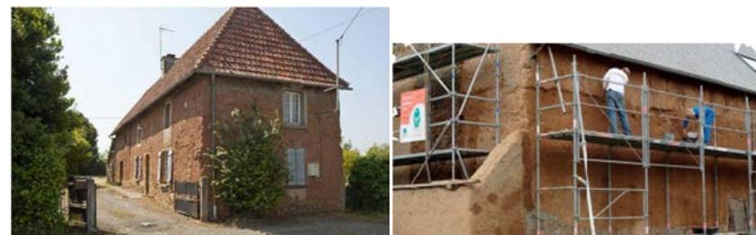
Photo 18 - Bâti en bauge et chantier de rénovation de façade.
